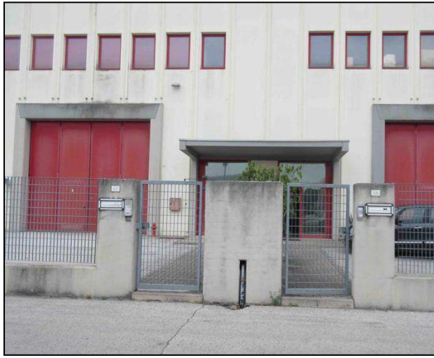
ingressi lato fronte strada
