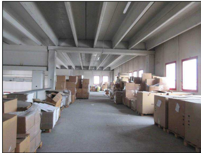
locale soppalco P2 al grezzo
