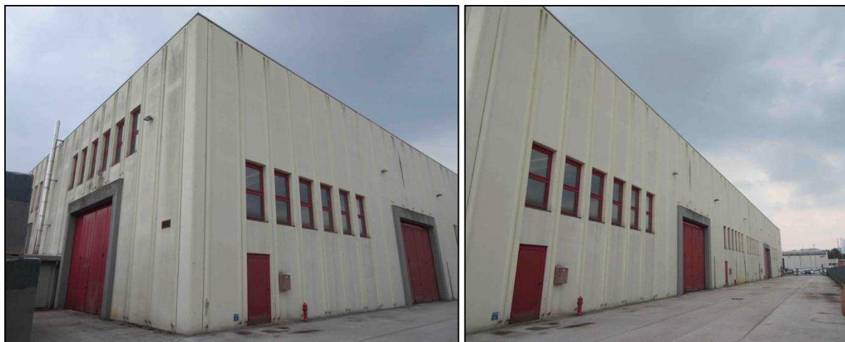
vista lati nord-ovest
